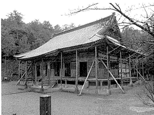
建造物3 えんじょうじほんどう 縁城寺本堂(京丹後市)
